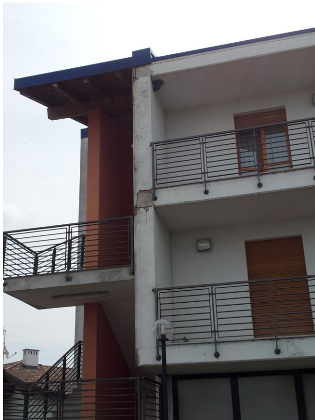
Foto 6-7: ammaloramento intonaci esterni
