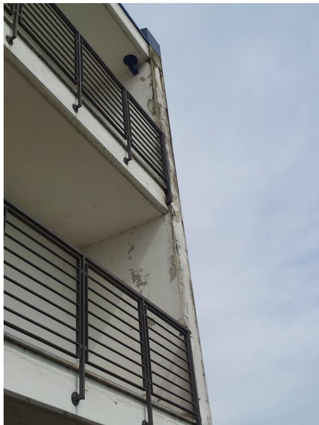
Foto 6-7: ammaloramento intonaci esterni
